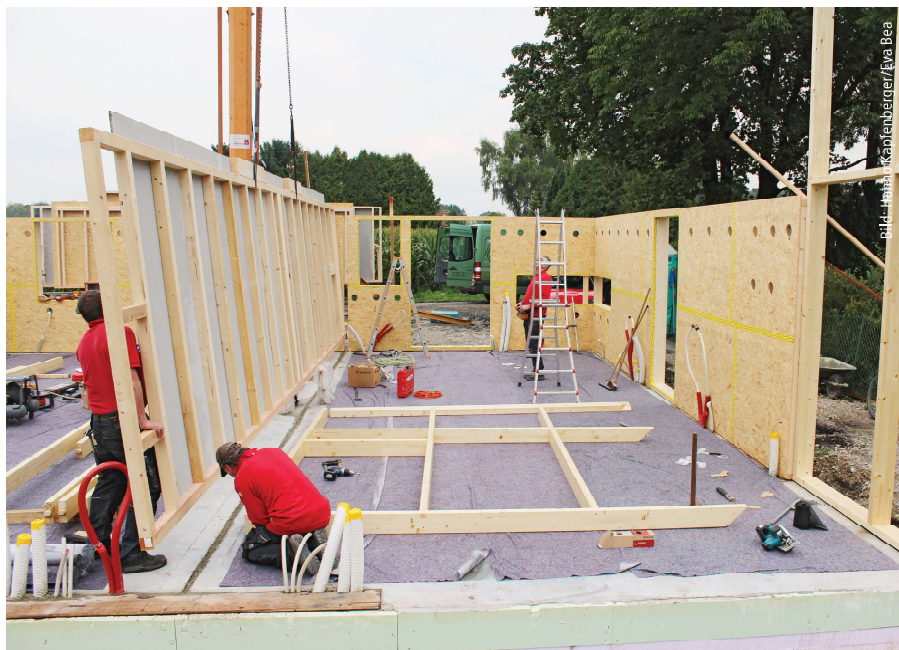
Die Ständerwerkelemente wurden direkt auf die geglättete und später geölte Bodenplatte gestellt und montiert.
