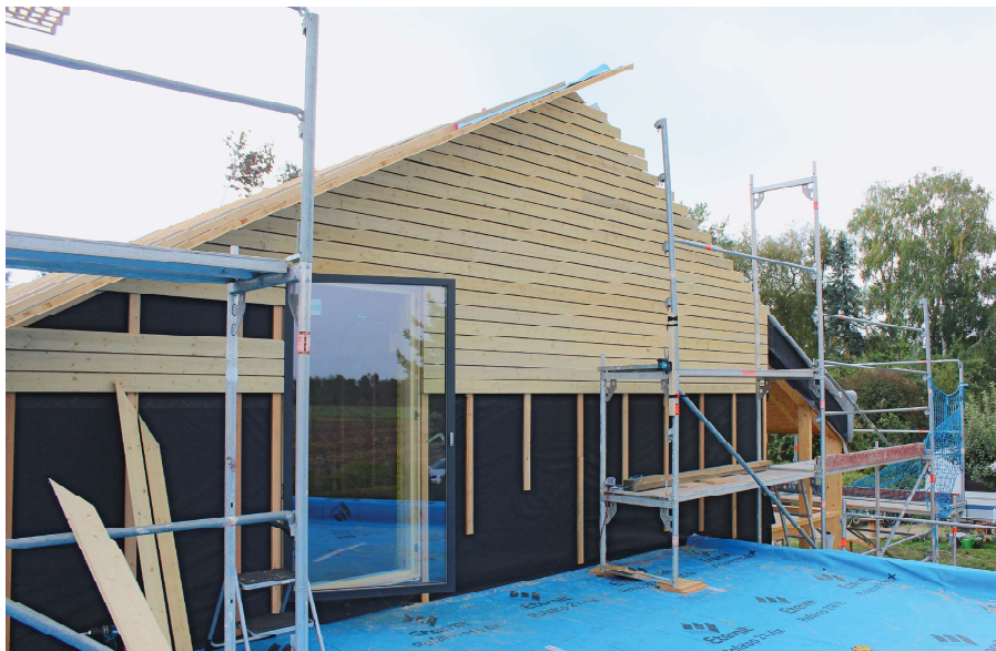
Die für die vorgehängte hinterlüftete Fassade verwendeten sägerauen Fichtelamellen wurden vor der Montage mit einem Eisenvitriol-Anstrich behandelt.
