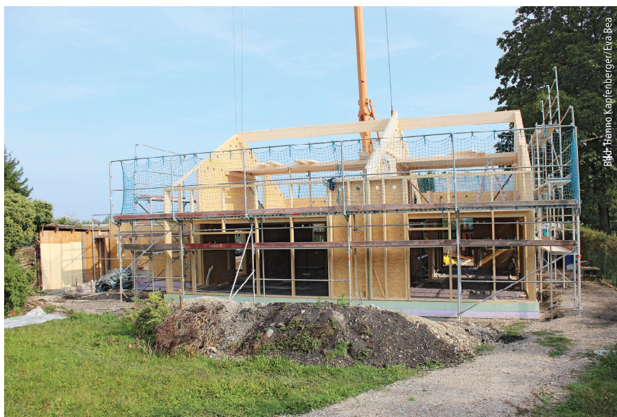
Die Zwischendecke des Dachgeschosses aus BSH-Elementen liegt wie die Decke über dem Erdgeschoss auf Lagerhölzern auf.
